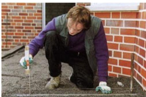
3. Размещение направляющей трубки
