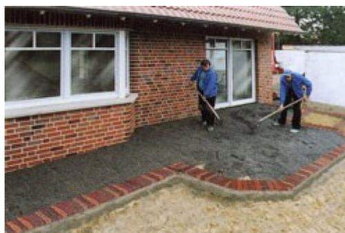
2. Равномерное распределение балласта
