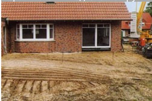
На поверхности, где планируется укладывать клинкерную брусчатку, должен быть снят верхний слой почвы, чтоб образовалось твердое земельное основание. Необходимо уплотнить и выровнять землю.
