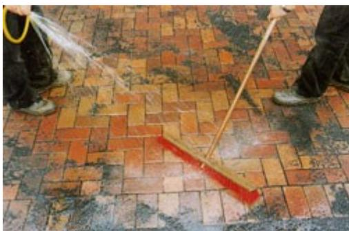
11. Заполнение швов с помощью веника и водной струи
