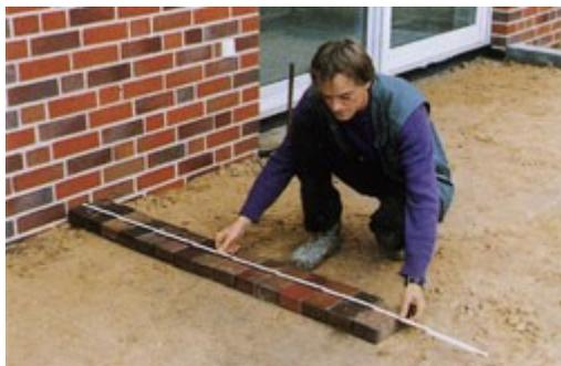
1. Укладка клинкера от стены здания для определения точных длины и ширины бордюра
