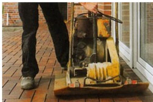
12. уплотнение мощеной поверхности выравнивающим вибрационным станком с резиновой основой
