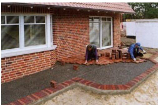
3. Линии укладки вымерены с помощью нитей, параллельно к стене дома и бордюру, идя от первого ряда
