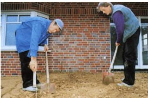
5. Распределение несущего слоя, согласно отмеренному нитью уклону
