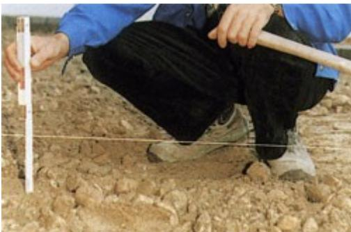
3. Фиксирование уклона нитью
