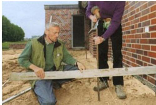
2. Установление уклона с помощью правила и ватерпаса
